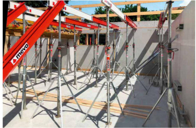
Deutlich weniger Stützen und mehr Bewegungsfreiheit. Integrierte Aufnahme- medorne ersetzen Trägergabeln und -krallen. Dreibeine dienen zur weiteren Sicherung der Stützen.
